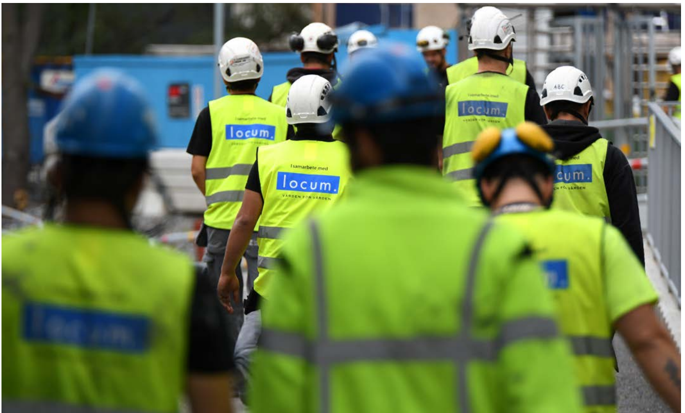
Ovan: Byggarbetsplats på Danderyds sjukhus.
