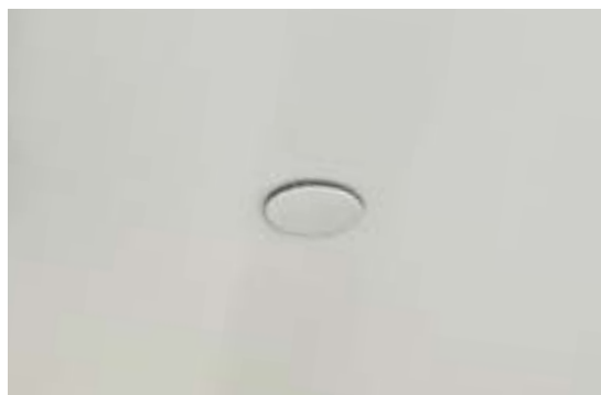
Dold sprinkler, kan sitta både i tak och vägg
