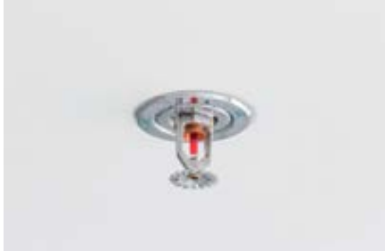
Sprinkler i tak
