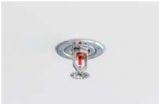
Sprinkler i tak
