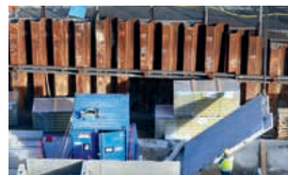
Det vanligaste sättet att sponta med falsar som krokas i varandra. På stora bilden används rörspont. BILD JOHAN RANNEMO
