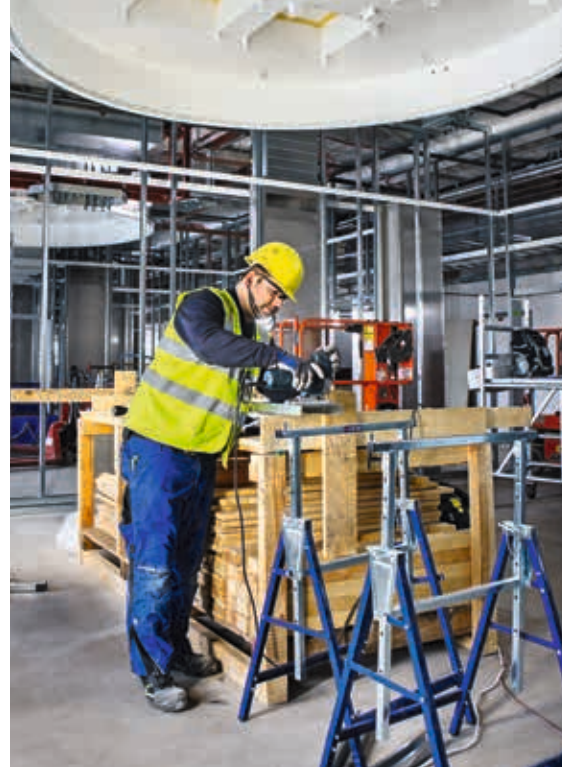
På operationsavdelningen tillverkas det som behövs för att kunna fästa de specialanpassade fläktfiltren i taket.
