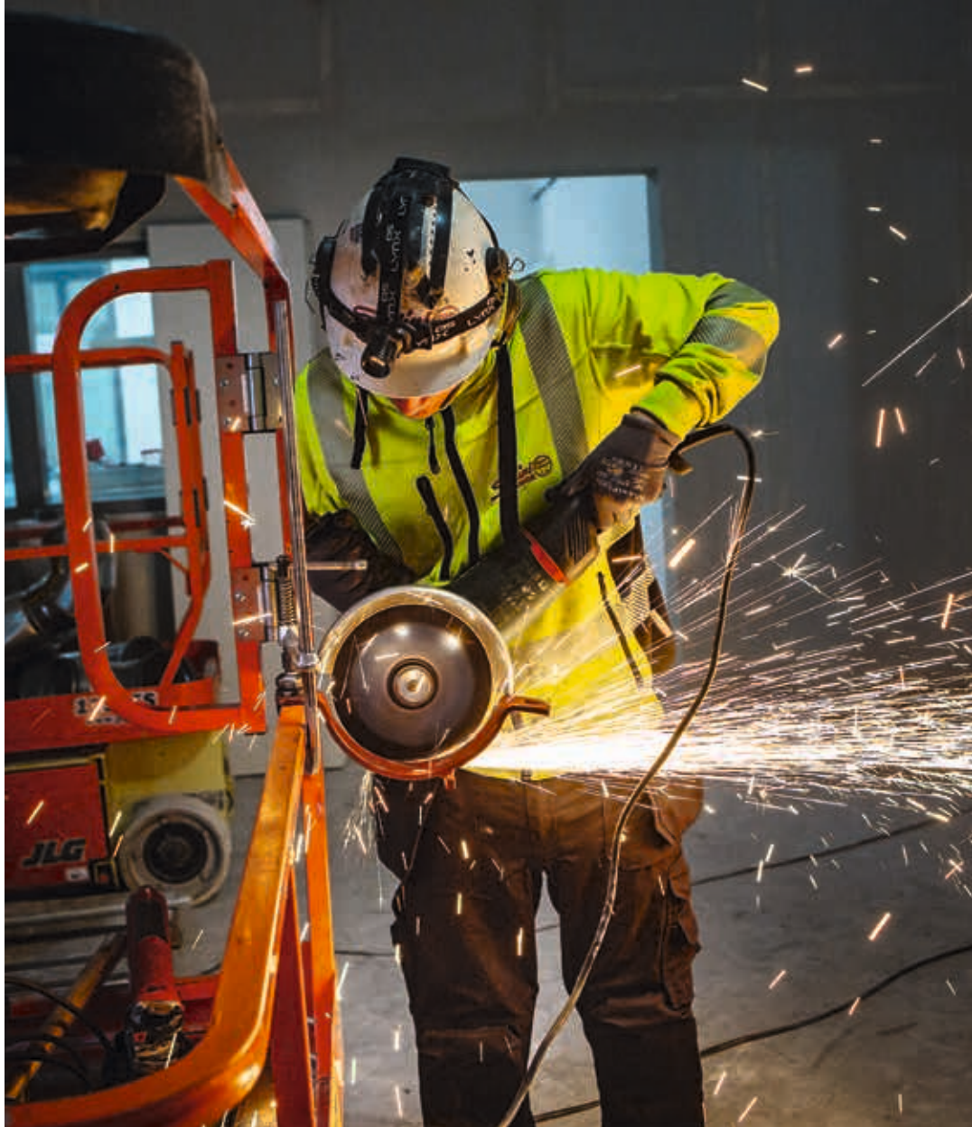
Förarbetet som krävs för att få den nya MR-kameran på plats pågår på den nya akutmottagningen i Södertälje.
