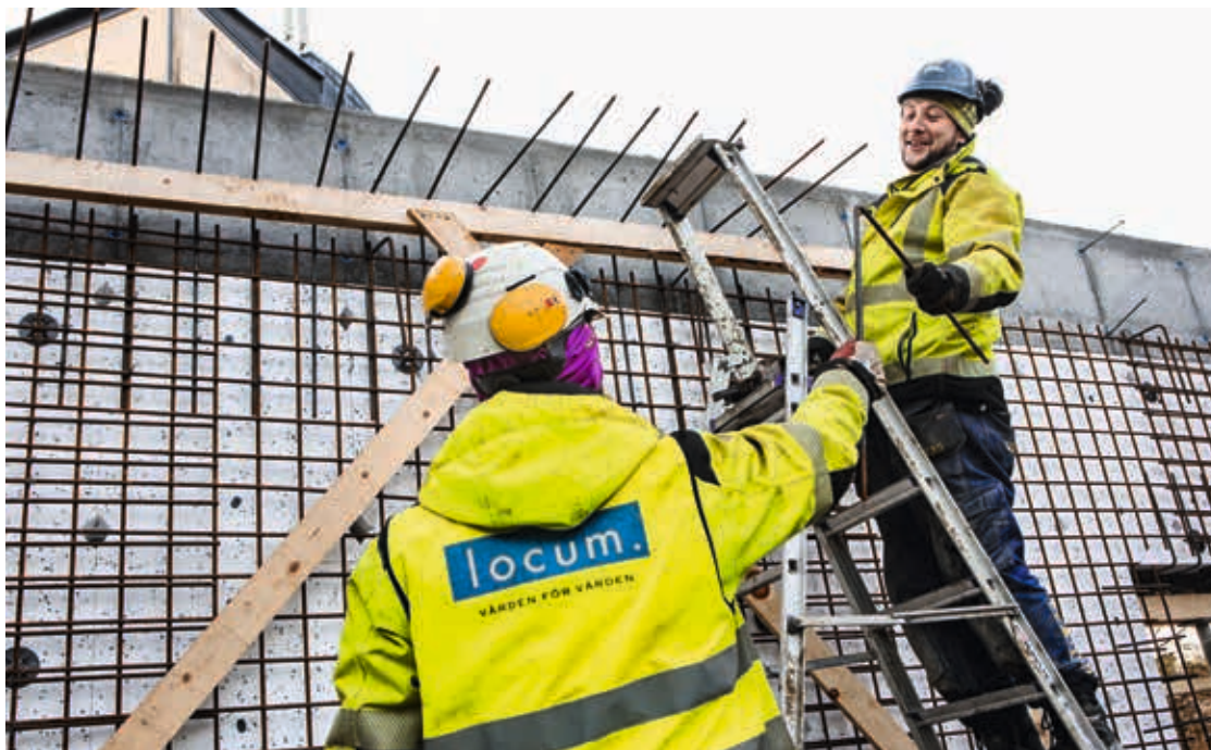
Admir Handabaka och Eldin Huskic arbetar på bygget av ett nytt hus för reservgas.
