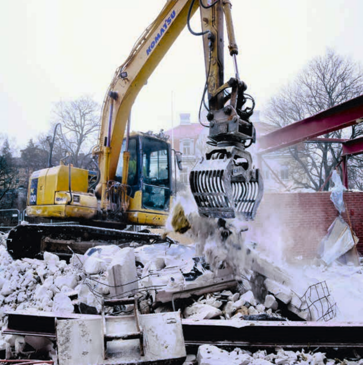
Rivningen av den gamla ambulanshallen gjordes med så få störningar som var möjligt. BILD SOL-BRITT ERIKSSON
