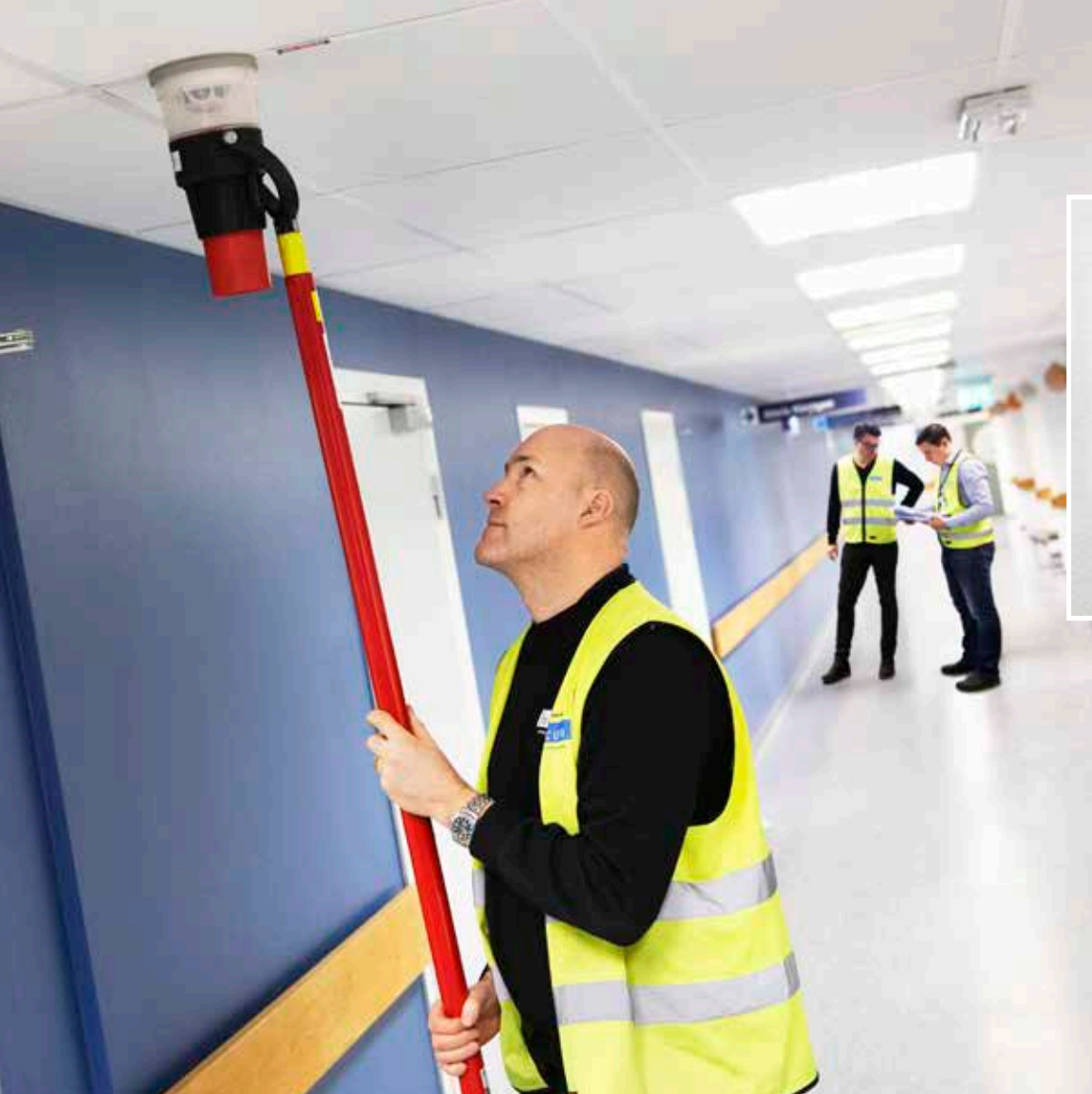
Rasmus Bjurvall testar en brandvarnare i en av de myndighetskontroller som kontinuerligt genomförs i de fastigheter som förvaltas av Locum.
