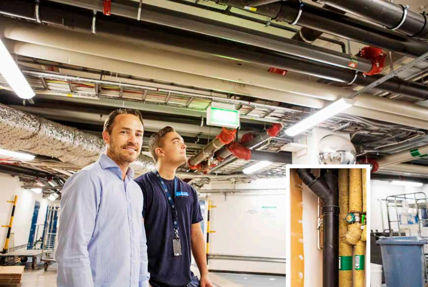
Locums projektledare Daniel Lindkvist och Mathias Wallman, drifttekniker på ISS, inspekterar de nya avloppsrören. Att de är tillverkade i plast ger dem lång livslängd.
