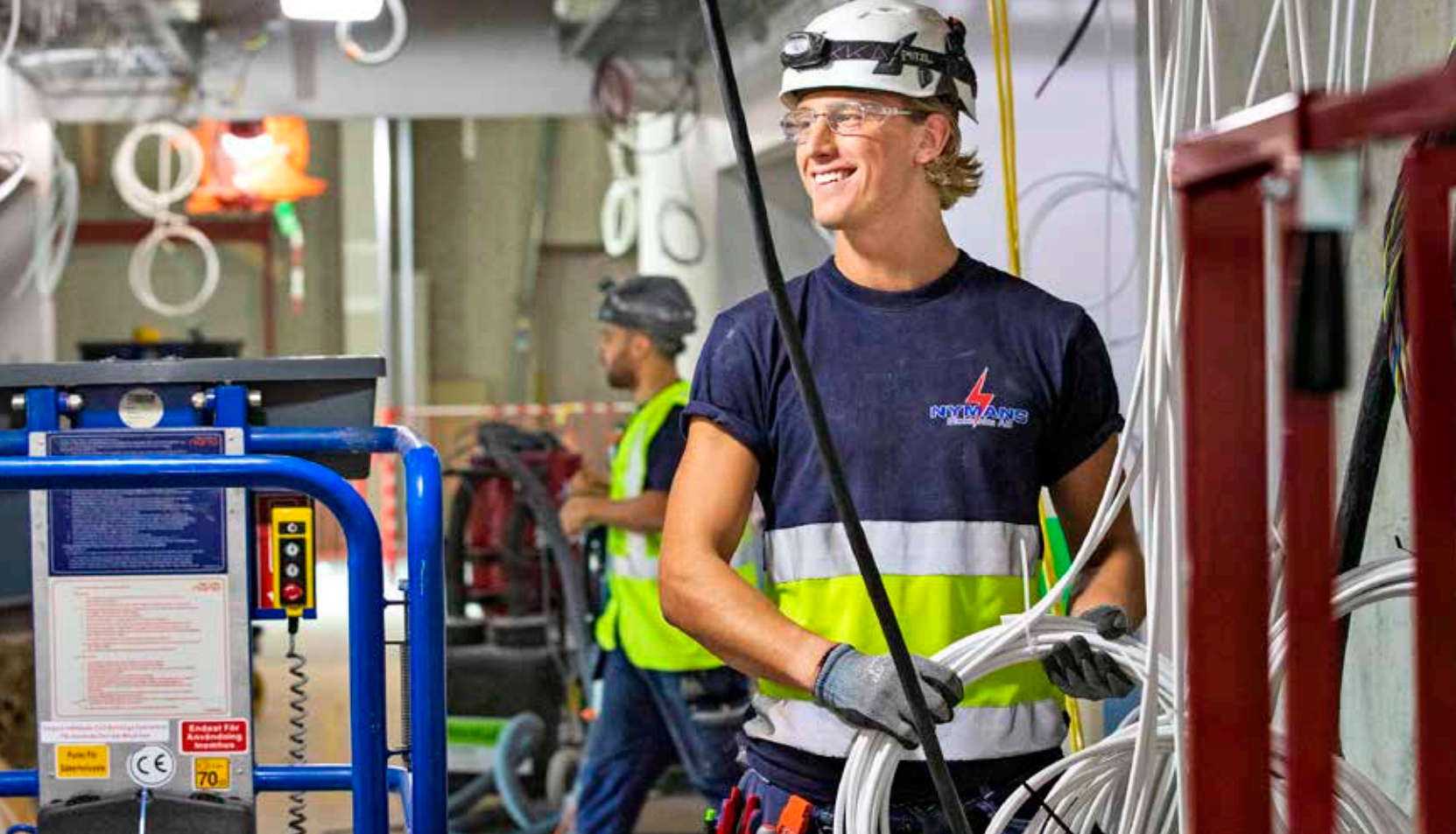
Viktor Norén Nevander är en av hundratals personer som arbetar med installationer i den nya behandlingsbyggnaden.
