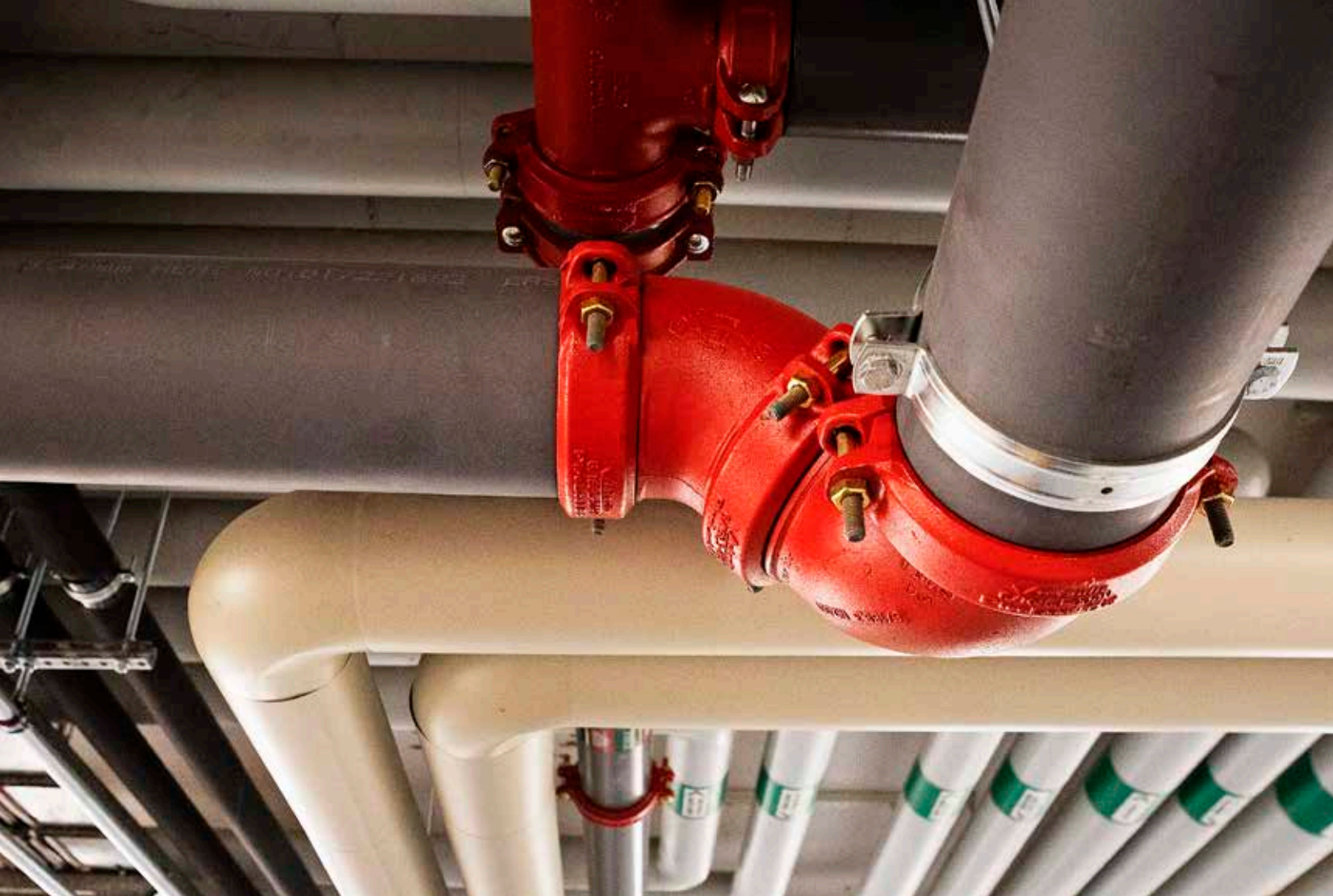
De gamla gjutjärnsrören vid S:t Görans sjukhus är nu utbytt mot plaströr.
