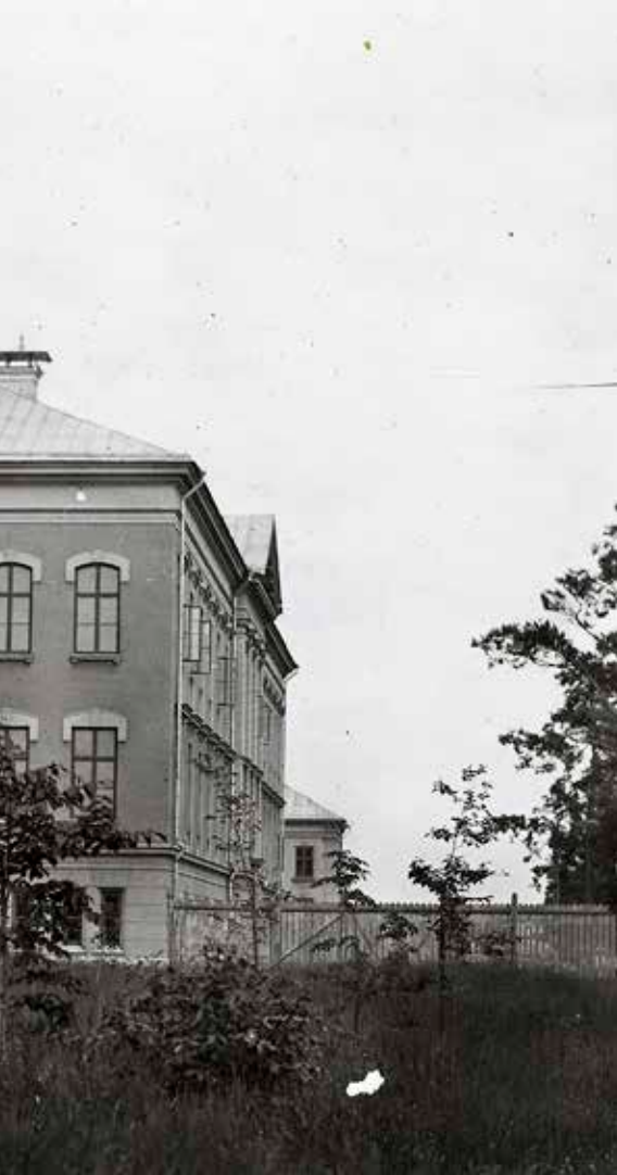
Centralbyggnaden vid S:t Göran fick luftombyte genom att frånluft skapades av fläktar och eld.
