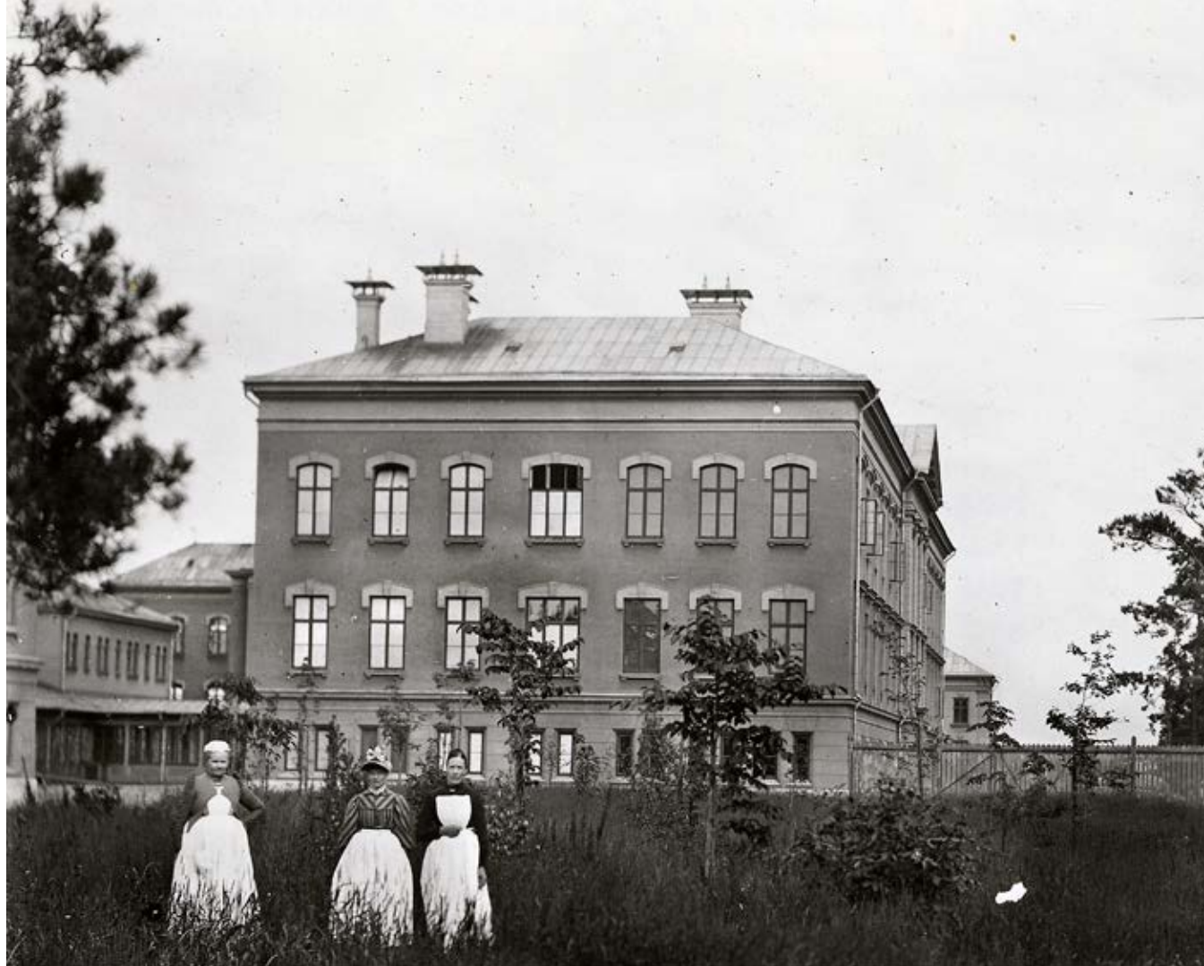
Centralbyggnaden vid S:t Göran fick luftombyte genom att frånluft skapades av fläktar och eld.
