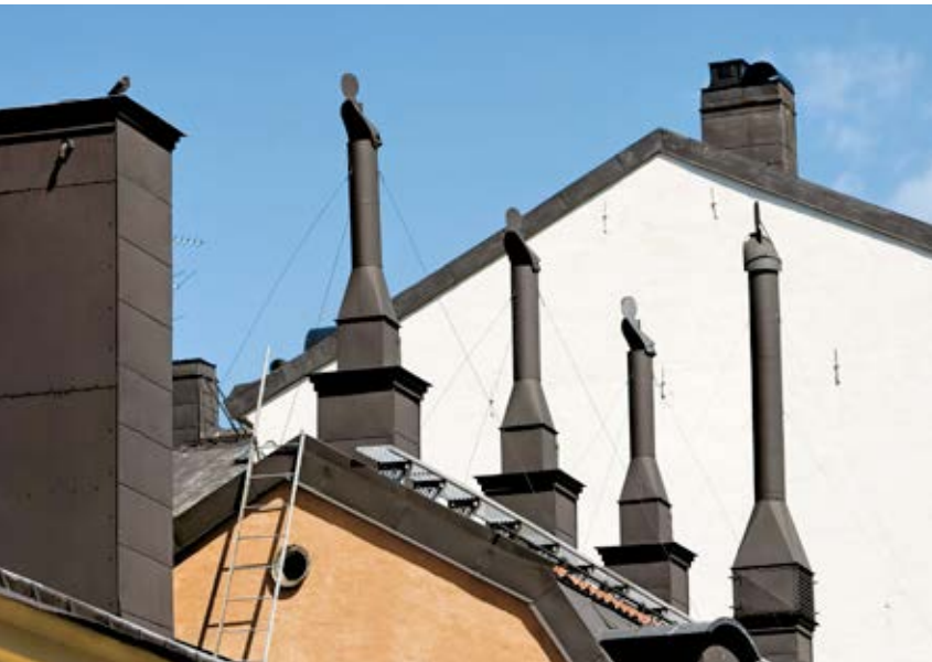
Vindflöjlar sätter fart på draget i ventilationen.
