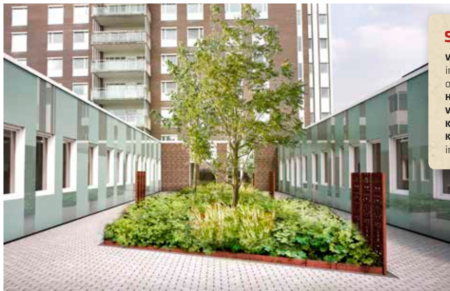
Helrenovering pågår i Sollentuna. BILD DORCONSULT
