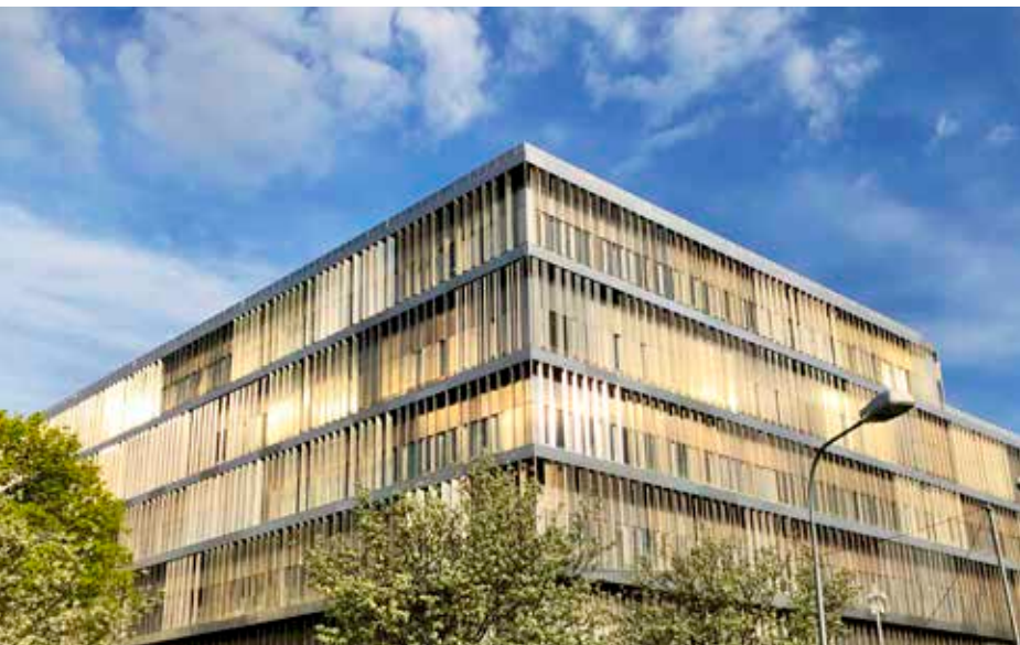
Nya akutvårdsbyggnaden i morgonljus. BILD MALIN WIGREN
