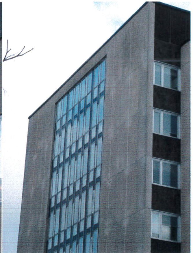
HUS 01, HÖGDEL FASAD MOT NORR, ALUMINIUMPARTI
