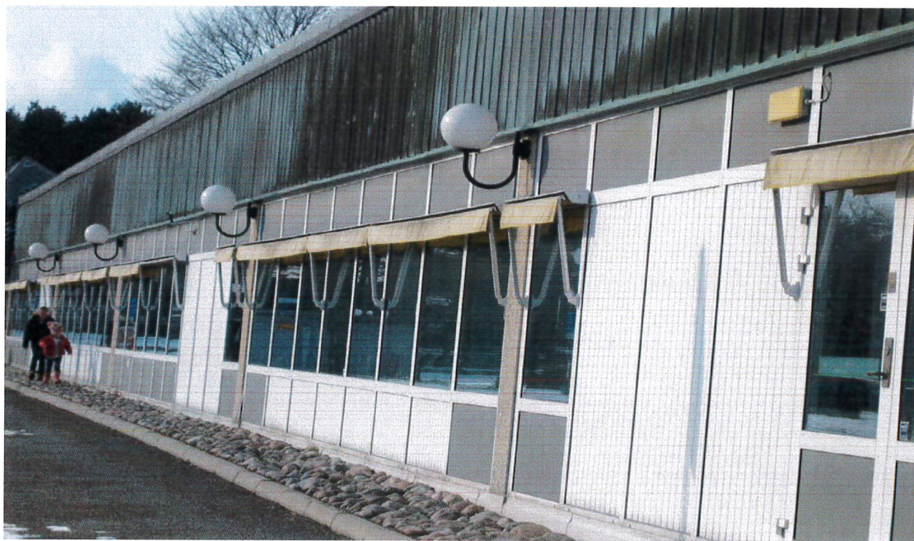
HUS 01, FASAD MOT SÖDER, UTBYTTA OCH FÖRÄNDRADE GLASPARTIER.
