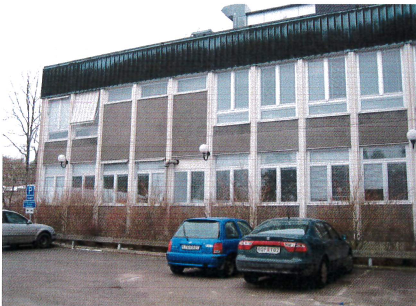
HUS 03, FASAD MOT SÖDER
