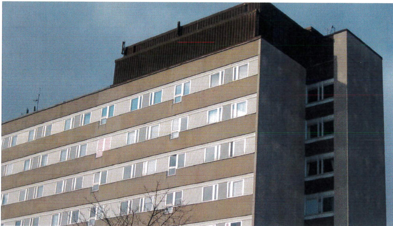
HUS 01, HÖGDEL FASAD MOT SÖDER, GAVEL MOT ÖSTER
