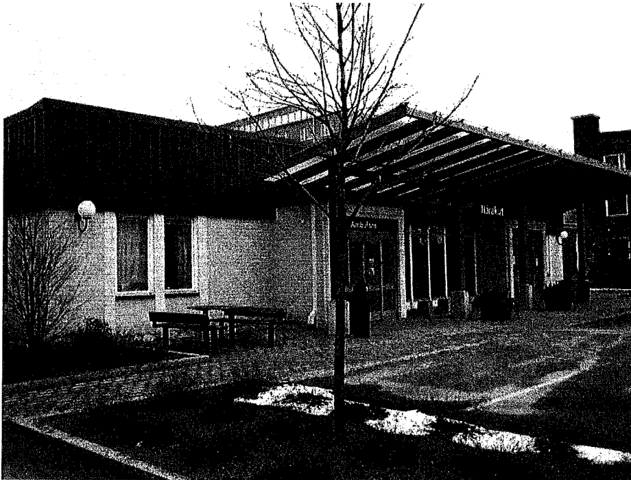
HUS 05, FASAD MOT SÖDER
