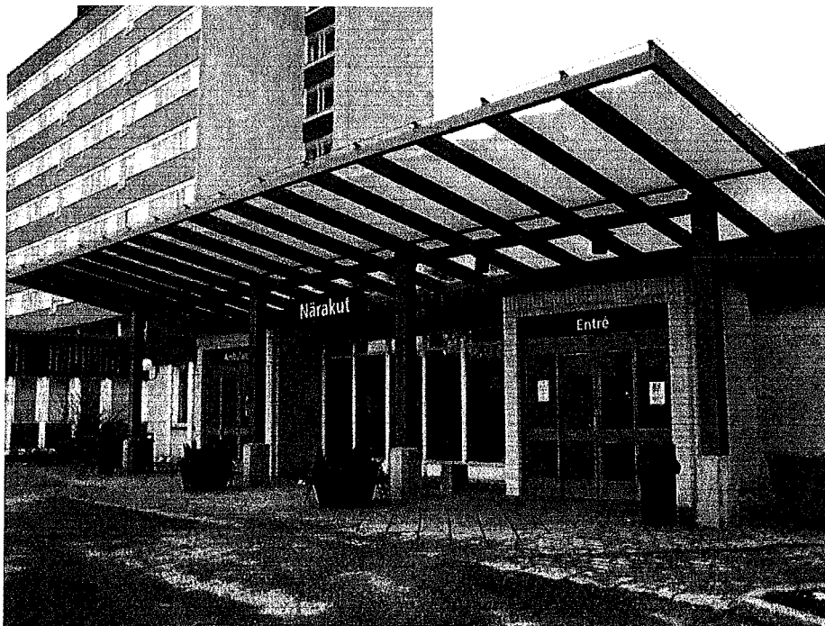
HUS 05, FASAD MOT SÖDER
