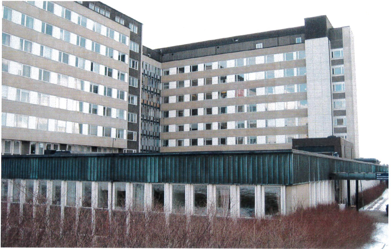
HUS 01, FASAD MOT NORR OCH VÄSTER
