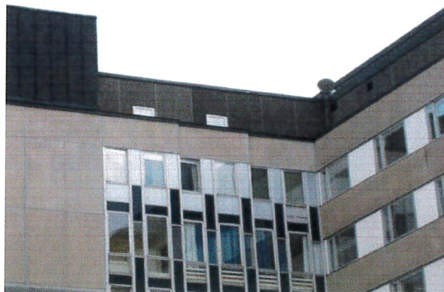
HUS 01, FASAD MOT VÄSTER ALUMINIUMPARTI I TRAPPHUS
