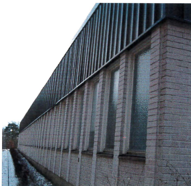
HUS 05, FASAD MOT ÖSTER
