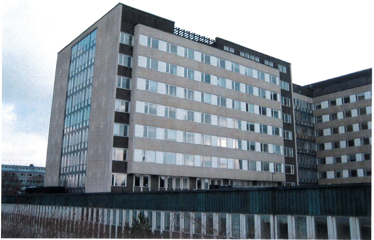
HUS 01, FASAD MOT VÄSTER
