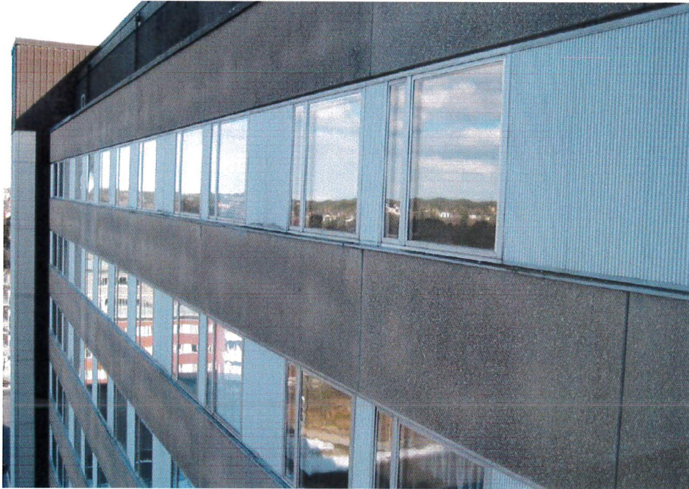
HUS 01, FASAD MOT NORR, URSPRUNGLIGA FÖNSTER OCH FÖNSTERBAND
