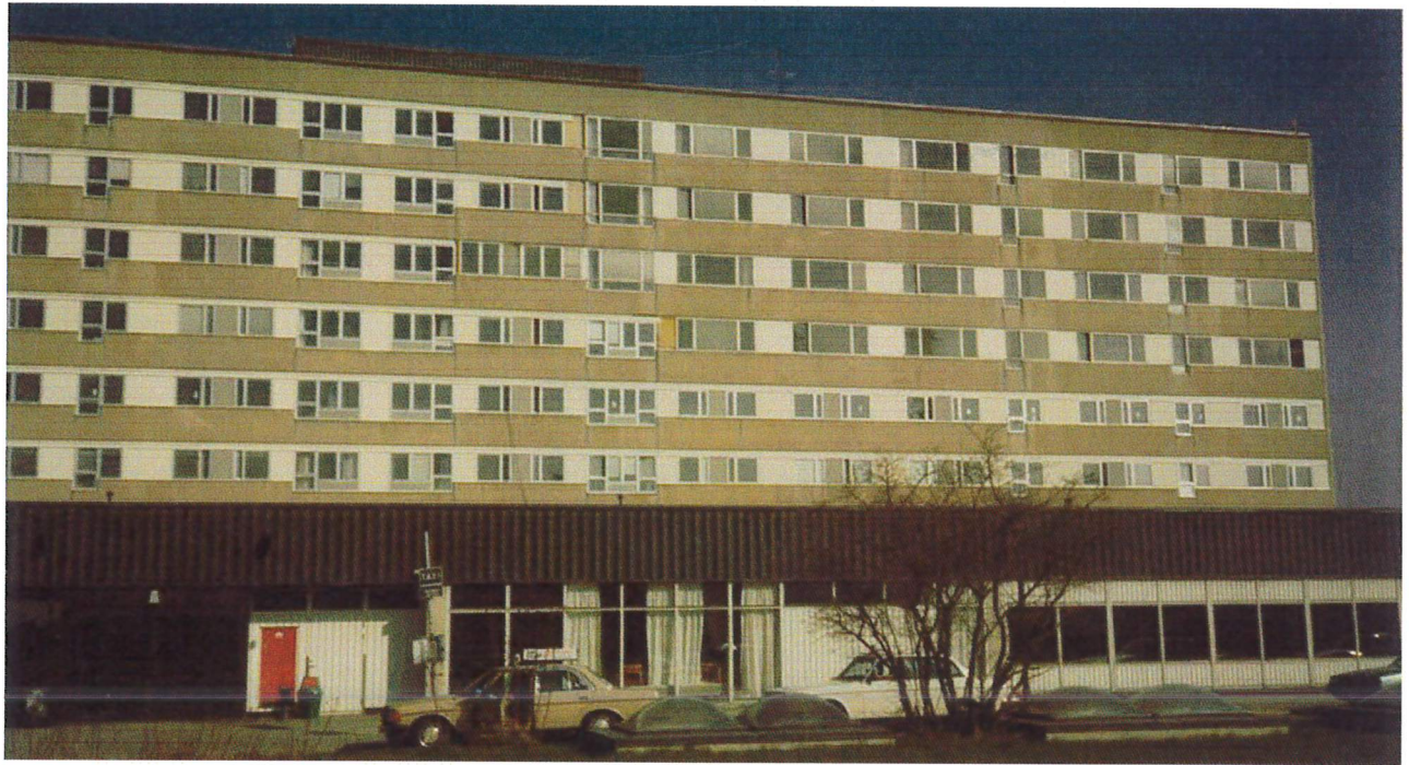
HUS 01, FASAD MOT SÖDER, FÖNSTERBAND MED ORIGINALFÖNSTER OCH DELVIS UTBYTTA OCH FÖRÄNDRADE FÖNSTER
