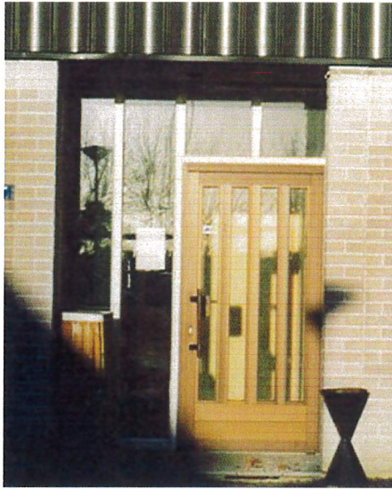
HUS 05, FASAD MOT SÖDER, UR- SPRUNGLIGT GLASPARTI OCH DÖRR
