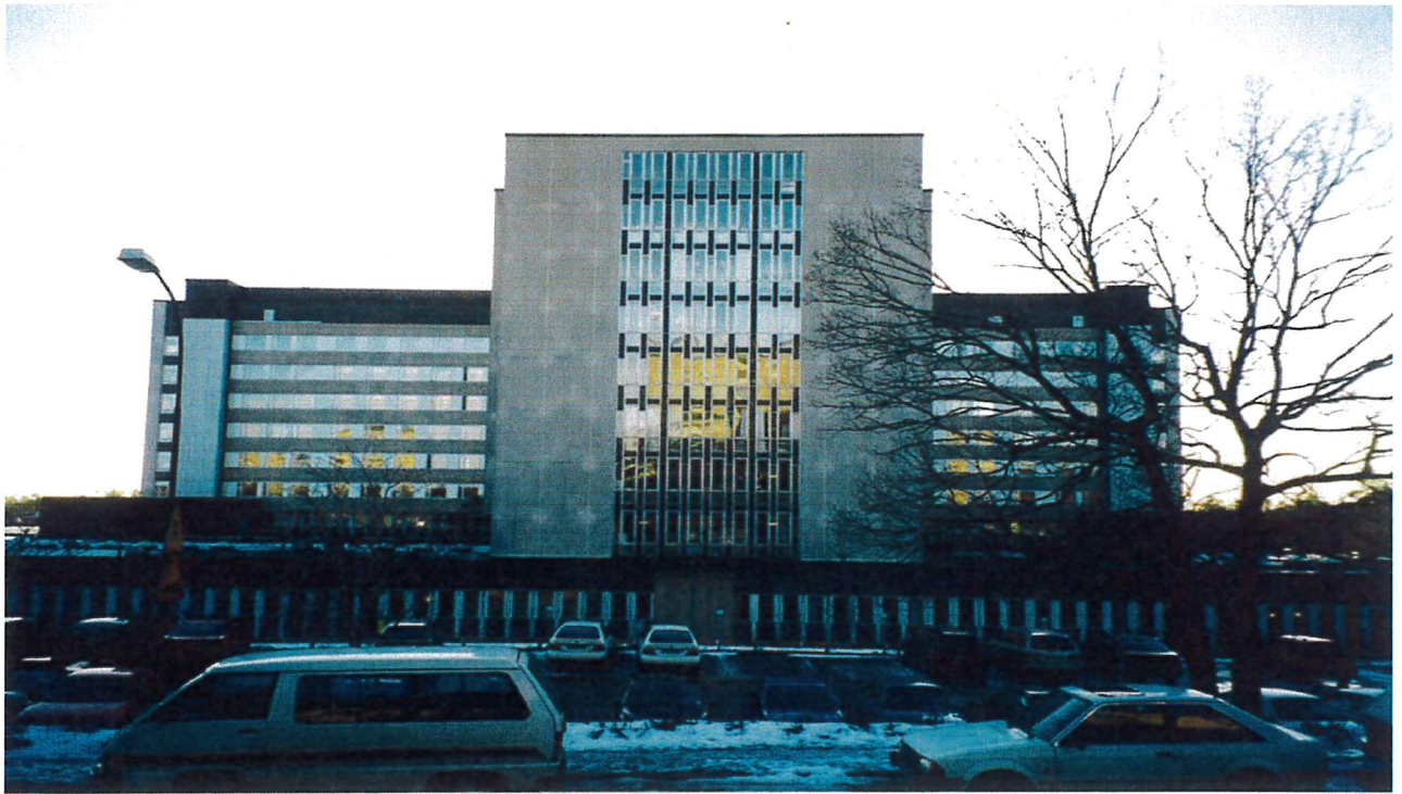
HUS 01, FASAD MOT NORR
