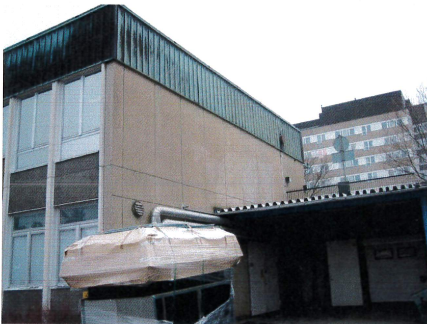
HUS 03, FASAD MOT ÖSTER
