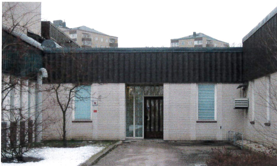
HUS 05, FASAD MOT SÖDER
