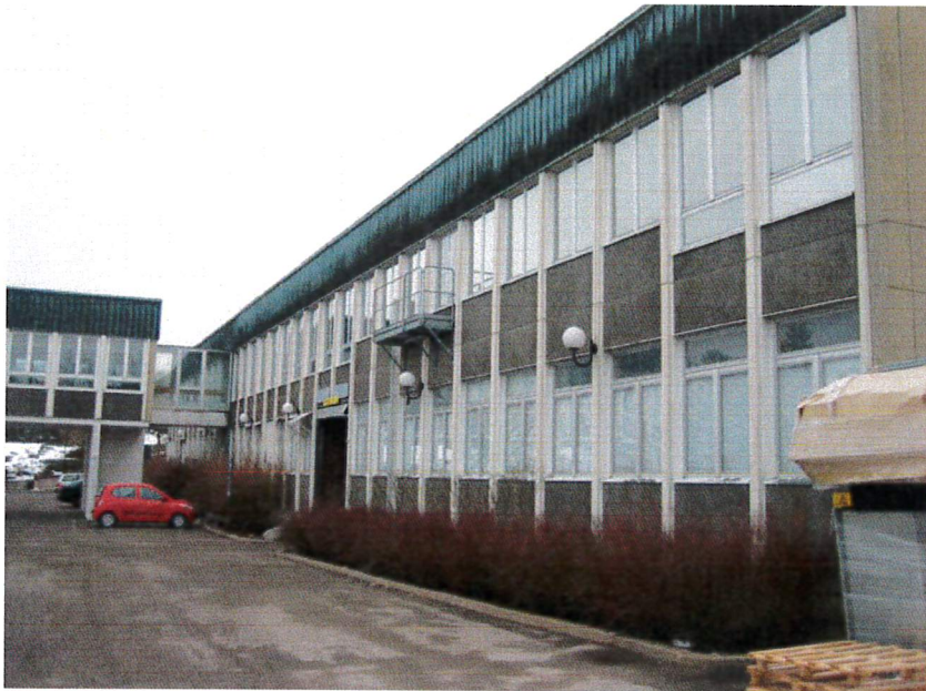
HUS 03, FASAD MOT SÖDER
