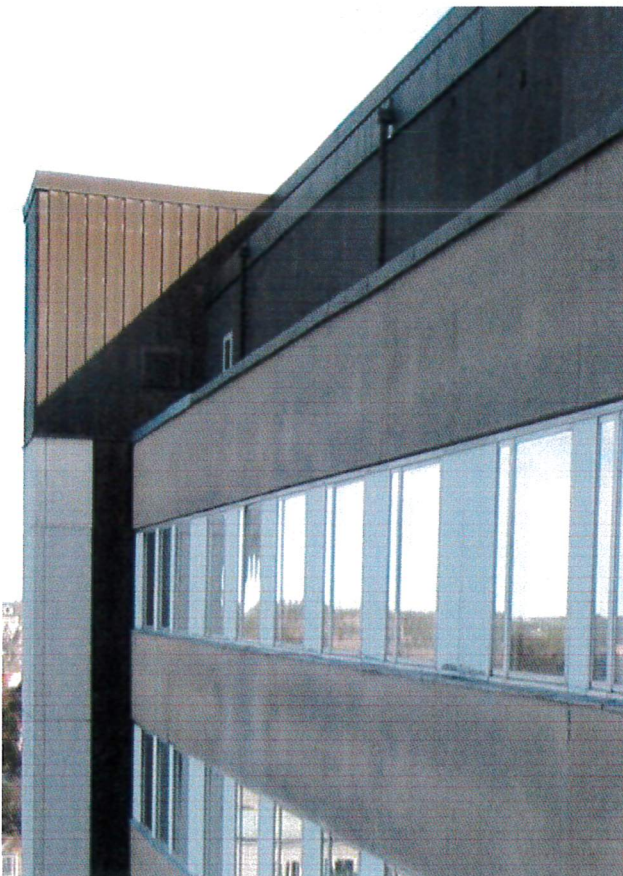
HUS 01, HÖGDEL FASAD MOT NORR, FÖNSTERBAND
