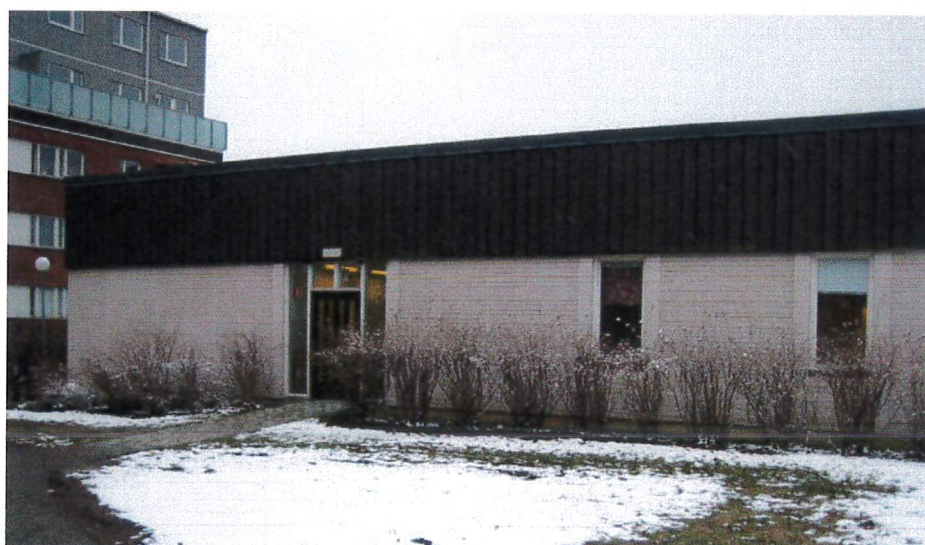
HUS 05, FASAD MOT NORR
