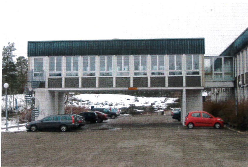
HUS 03, FASAD MOT ÖSTER
