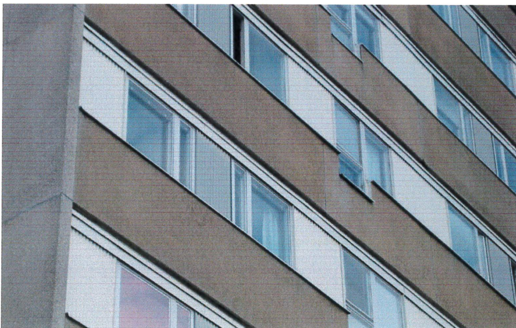
HUS 01, FASAD MOT SÖDER, UTBYTTA OCH FÖRÄNDRADE FÖNSTER I FÖNSTERBAND
