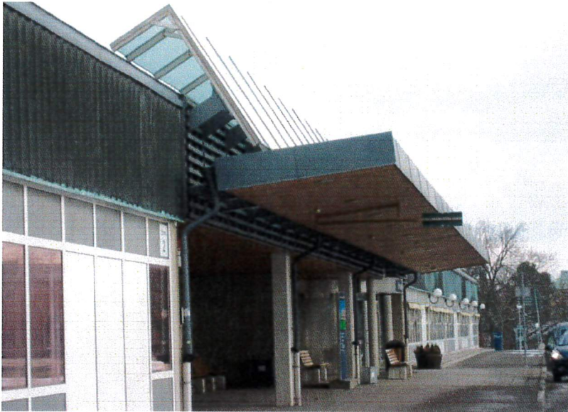
HUS 01, LÅGDEL FASAD MOT SÖDER HUVUDENTRÉ
