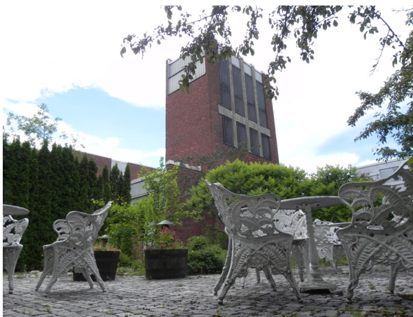
Ventilationstorn. Foto: Locums bildarkiv
