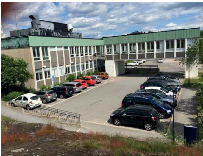
Nacka sjukhus byggnad 03 före rivning av matsalsdelen
