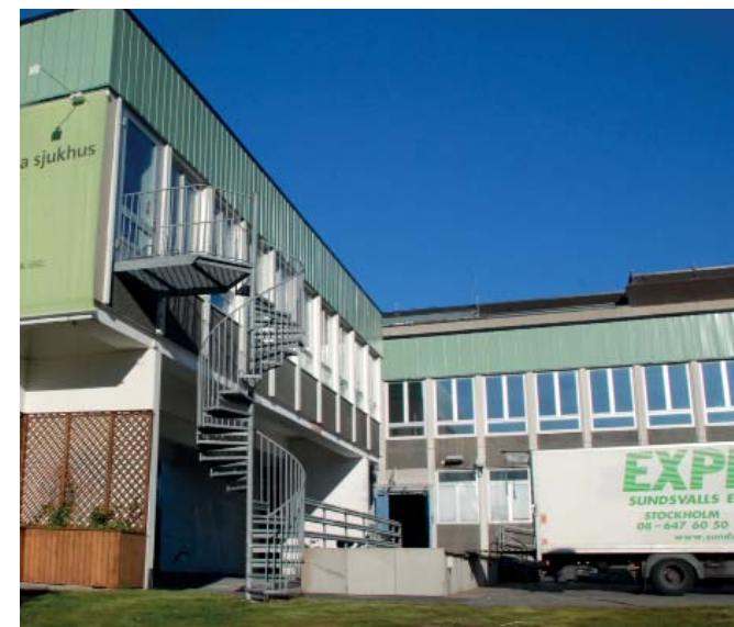
Befintlig lastkaj saknar klimatskydd. Matsalen - den utskjutande byggnadsdelen - är nu riven.
