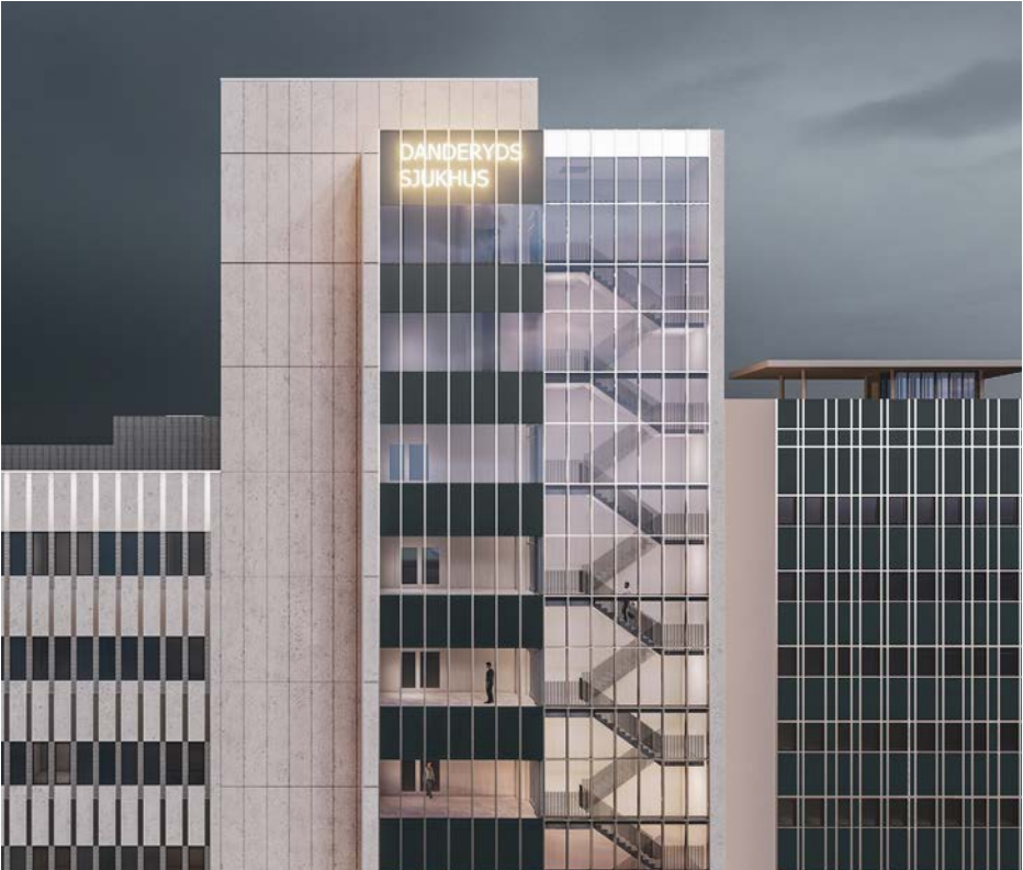
Huvudtrapphuset -Befintlig struktur möter ny
